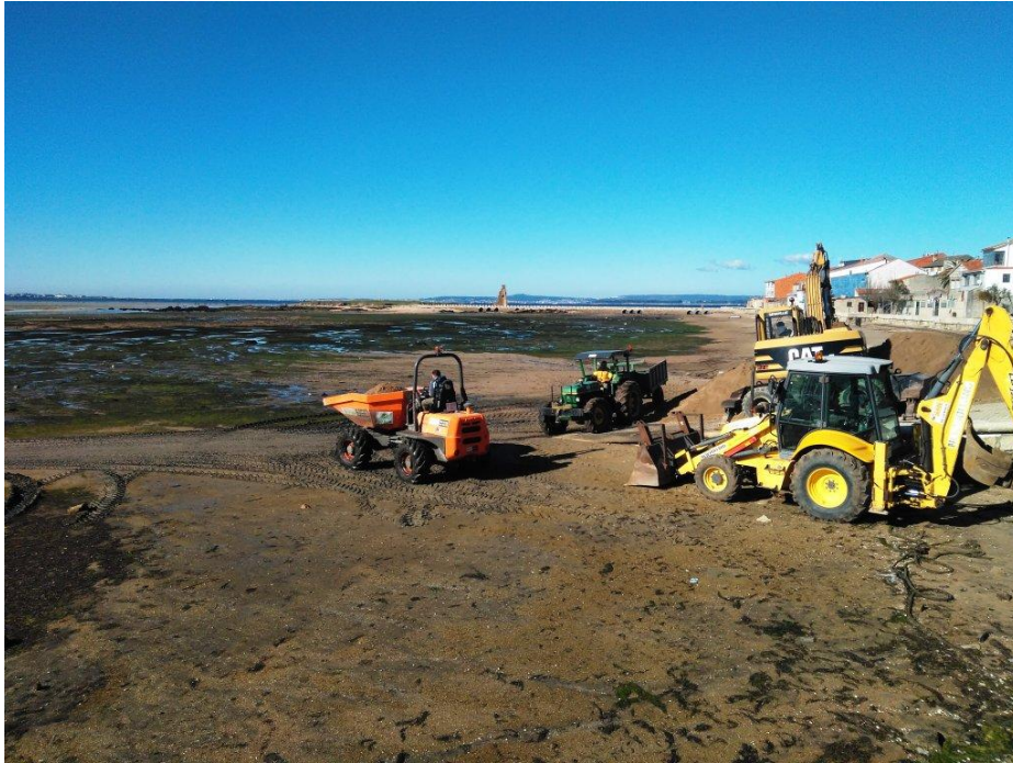
Figura 5.- Maquinaria empregada no acondicionamento da zona “Matadero”
